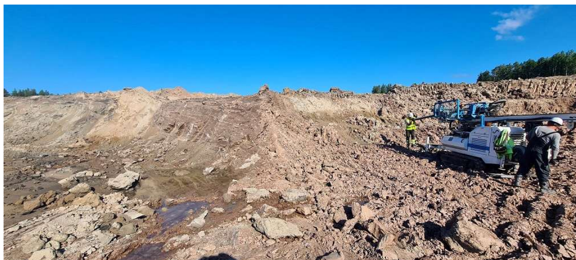
Foto 3.2. Puuraukude rajamine Arumetsa II savikarjääri mäeeraldisel, puurauk 11a-24 läheduses (Sven Siir, 05.06.2024, N 58°03'31" ja E 24°31'50").
