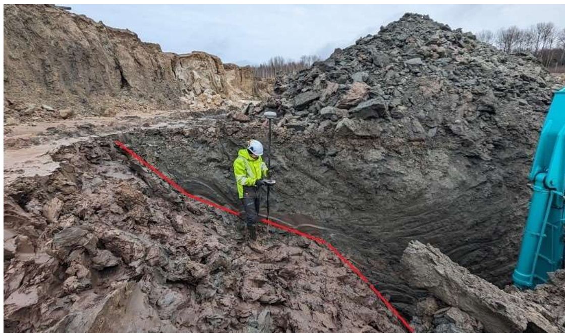
Foto 4.4. Kaevandis K-5 muutus Q väikesel vahemaal. Q 5,8 m (kasuliku kihi lasum abs 5,01 m). Varasematel andmetel oli kasuliku kihi lasum abs kõrgusel ~10,5 m. Tegelik Q ~5 m suurem (N 58°03'30" ja E 24°31'48").
